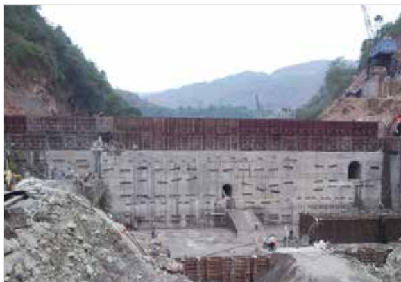
在工人进行防水施工前，共挖土130万方
